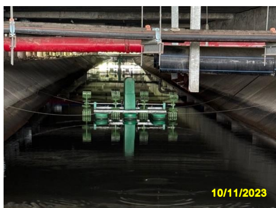
รูปที่ 2-23 เครื่องเติมอากาศ บริเวณบ่อพักน้ำเสียที่ผ่านการบำบัด ภายในพื้นที่ศูนย์ซ่อมบำรุง
