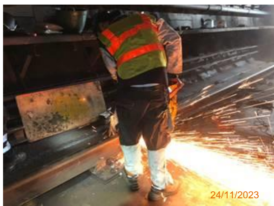
รูปที่ 2-5 การตรวจสอบและซ่อมบำรุงรางรถไฟฟ้าอย่างสม่ำเสมอ
